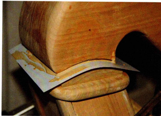
Afb. 11: De hals wordt niet aan de klankkast verlijmd, maar staat er los op; om zijdelings verschuiven te voorkomen is er wel een los (niet vastgelijmd) deuveltje geplaatst.
